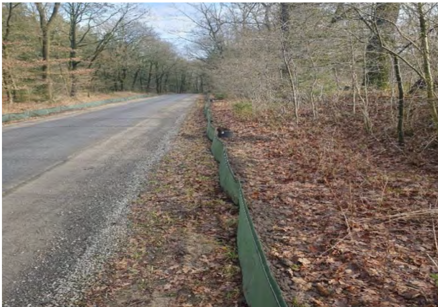
Amphibienzaun beidseitig an der Straße „Baumweg“ (Foto: KÜFOG, Klawitter)
